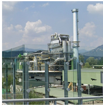
- IT_0010 - COMO INCINERATION PLANT - TERMOVALORIZZATORE DI COMO - 85,756 tonnes. 5.8MWe, 39MWt
