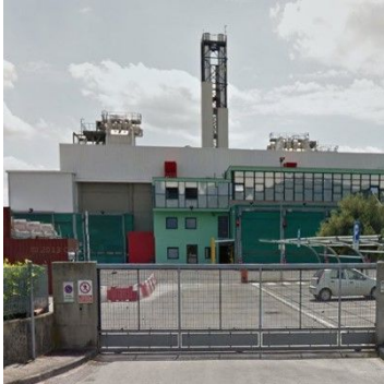
- IT_0031 - MONTALE INCINERATION PLANT - TERMOVALORIZZATORE DI MONTALE - 41,190 tonnes. 7.7MWe, 28.5MWt
