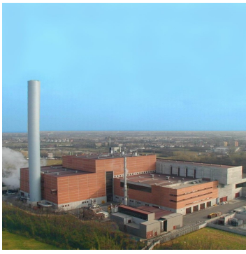
- IT_0029 - MILANO - SILLA INCINERATION PLANT - TERMOVALORIZZATORE SILLA 2 - 572,339 tonnes. 59MWe, 196.9MWt
