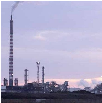
- IT_0047 - SCARLINO INCINERATION PLANT - COGENERATORE DI SCARLINO - 156,812 tonnes. 18.5MWe, 75MWt
