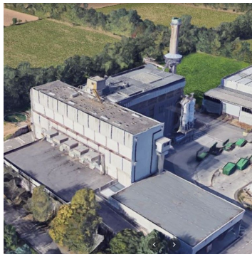
- IT_0015 - DESIO INCINERATION PLANT - TERMOVALORIZZATORE DI DESIO - 90,128 tonnes. 8.25MWe, 42MWt
