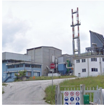
- IT_0040 - POTENZA INCINERATION PLANT - VEOLIA SERVIZI AMBIENTALI SPA - 24,000 tonnes. 1.2MWe
