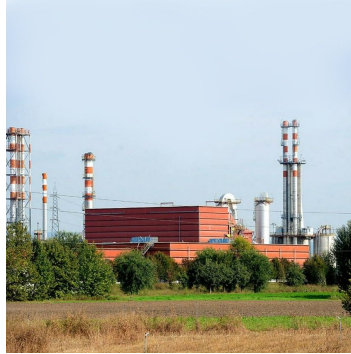
- IT_0058 - VERONA - CA'DEL BUE INCINERATION PLANT - TERMOVALORIZZATORE CÀ DEL BUE - 192,000 tonnes.
