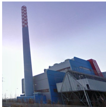
- IT_0054 - TREZZO SULL'ADDA INCINERATION PLANT - TERMO TREZZO - 147,677 tonnes. 20.2MW e , 82.4MWt
