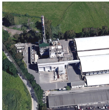
- IT_0044 - ROMA - MALAGROTTA INCINERATION PLANT - INCENERITORE DI MALAGROTTA - 14,600 tonnes. 36MWe
