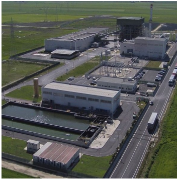
- IT_0059 - MANFREDONIA INCINERATION PLANT - ENERGIE TECNOLOGIE AMBIENTE S.R.L. (ETA) - 147,000 tonnes. 14MW e , 61.9MWt
