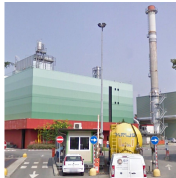
- IT_0004 - BERGAMO INCINERATION PLANT - TERMOVALORIZZATORE DI BERGAMO - 55,005 tonnes. 10.6MWe, 48MWt
