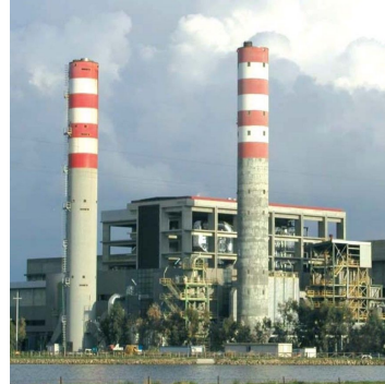
- IT_0024 - MACCHIAREDDU (CAPOTERRA) INCINERATION PLANT - TECNOCASIC SPA - 136,724 tonnes. 9.4MWe, 254MWt
