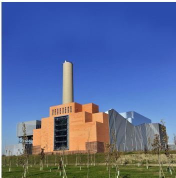
- IT_0035 - PARMA INCINERATION PLANT - INCENERITORE DI PARMA - 160,701 tonnes. 17.8MWe, 71.4MWt
