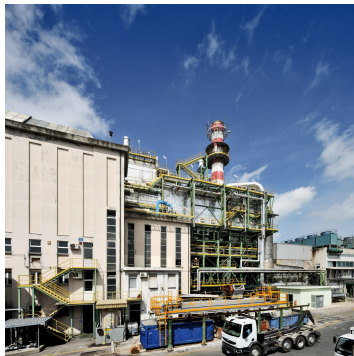
- IT_0023 - LIVORNO INCINERATION PLANT - TERMOVALORIZZATORE DI LIVORNO - 69,890 tonnes. 6.7MWe, 31.2MWt
