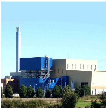
- IT_0037 - PIACENZA INCINERATION PLANT - TECNOBORGO SPA - 114,231 tonnes. 12MWe, 45.3MWt
