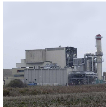
- IT_0032 - OSPEDALETTO INCINERATION PLANT - TERMOVALORIZZATORE DI PISA - 69,000 tonnes. 4.4MWe, 20.5MWt
