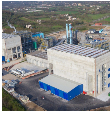
- IT_0046 - SAN VITTORE DEL LAZIO INCINERATION PLANT - INCENERATORE DI SAN VITTORE DEL LAZIO - 357,174 tonnes. 51.3MW e , 160MWt
